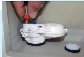
O mecanismo já vem pré regulado para 6 litros de água, em havendo necessidade de mais ou menos água, **gire o botão vermelho para a direita para obter mais água e para a esquerda para obter menos água. Sempre girando ¼ de volta e aguardando o enchimento da caixa.**
